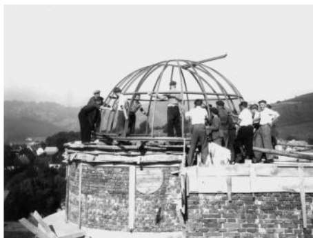
Obr.1: Usazení kovové konstrukce kopule, červen 1949.
