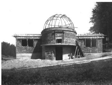
Obr.2: Pohled na dokončenou hrubou stavbu hvězdárny, červen 1949.
