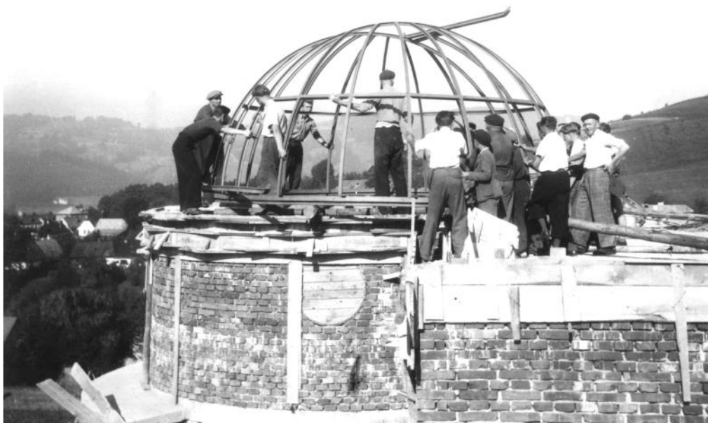
Historická fotografie z roku 1950, zachycující uzazení kovové konstrukce kopule Hvězdárny Vsetín.
