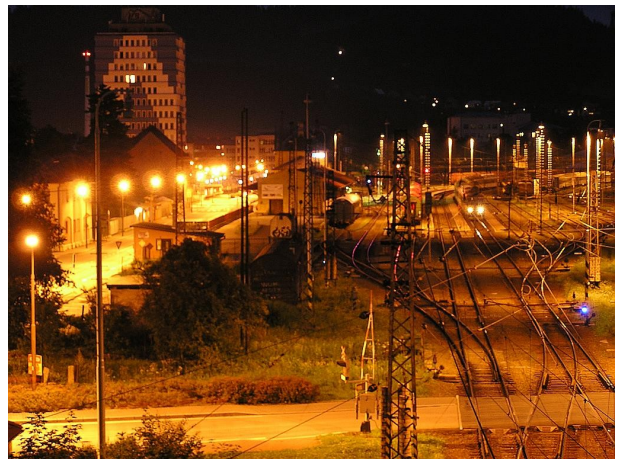
Obr. 1: Vpravo nádraží na Vsetíně, které je osvětleno správně (tj. nejde vidět zdroj světla). Vlevo příklad nejhoršího možného osvětlení pomocí svítících koulí, které oslňují a svítí všemi směry.
