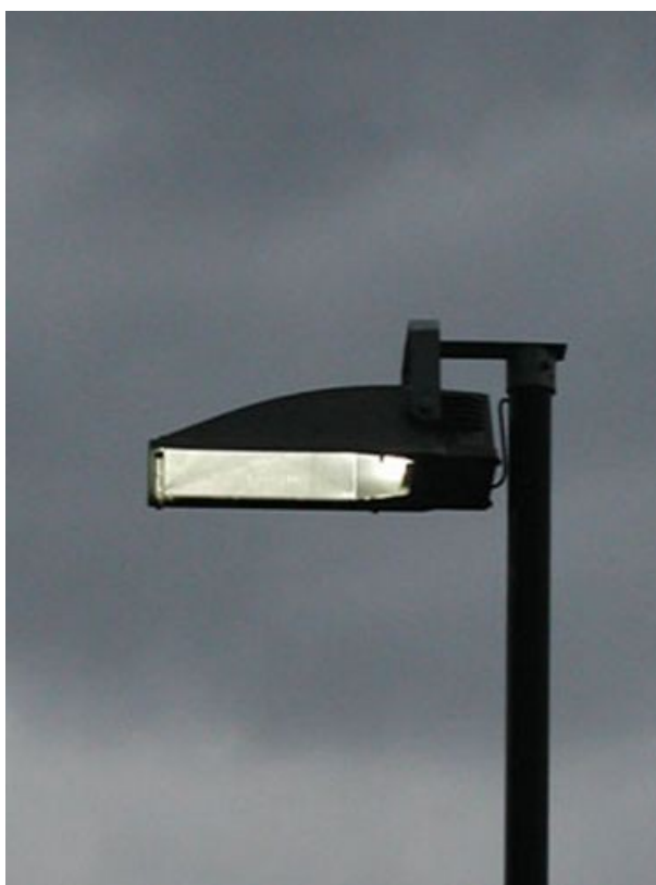
Obr. 6: Dobrý příklad osvětlení svítidlem, které svítí jenom dolů. Takovéto svítidla můžeme vidět např. v tenisovém areálu Hamr sport Praha – Hostivař.
