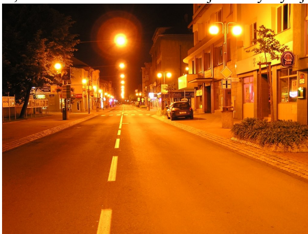
Obr. 2: Smetanova ulice na Vsetíně, které je osvětlena naprosto nevhodně pomocí svítidel, která svítí všemi směry a oslňují, což je vidět i z fotografie.
